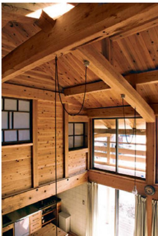
二階階段室から吹き抜けとベランダを見る。地棟と登り梁に支えられた小屋裏から光が差し込む。内部建具には古建具を再利用。
