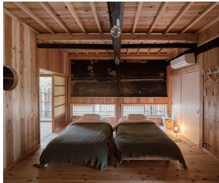
既存の梁や土壁を現した板の間。
