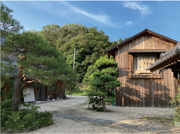
母家南側に位置する蔵。土壁は傷んでいたため、板張りとした。
