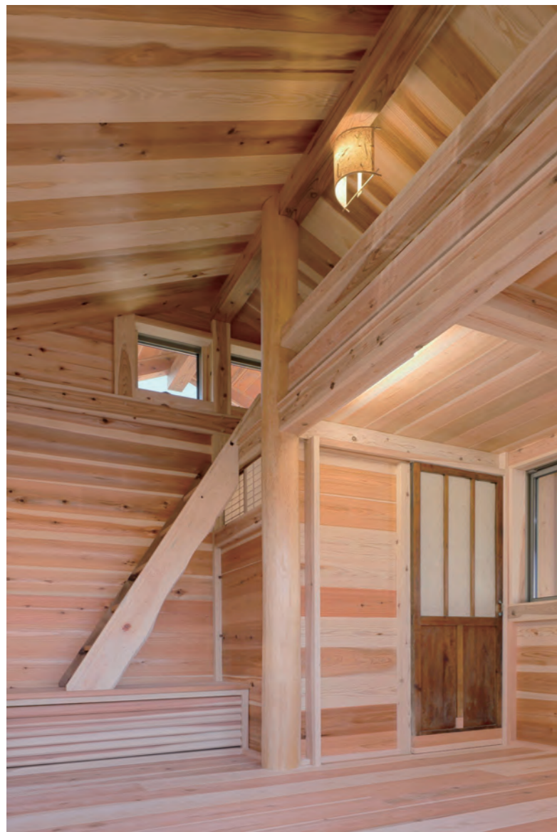
上/平面の半分にロフトを設ける 下/右奥が水回り。その左に階段と床下のエアコンの収納スペース
