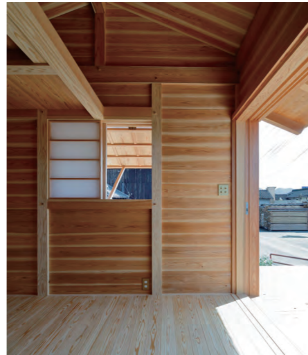
柱は板目づかいの割角材。床は木目を現した浮造り仕上げ
