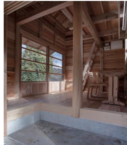
研究机上部のロフトを丸柱が部屋中央でしっかりと支える
