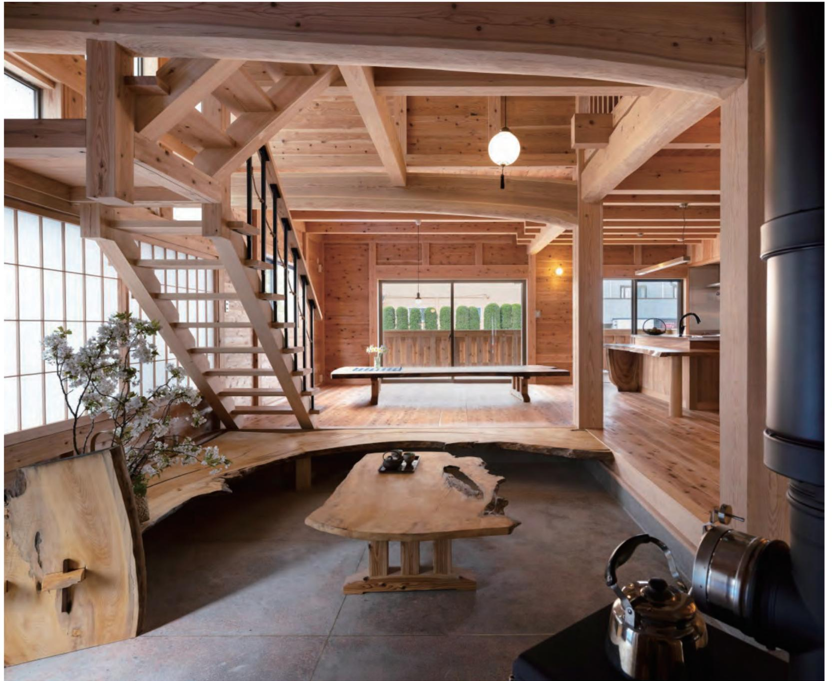
土間から階段・吹き抜け越しに居間と食堂。その奥にテラスを望む。大黒柱は8寸角、恵比寿柱は7寸角。共にスギの通し柱。
