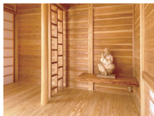
象徴的な丸柱がロフトを支えている
