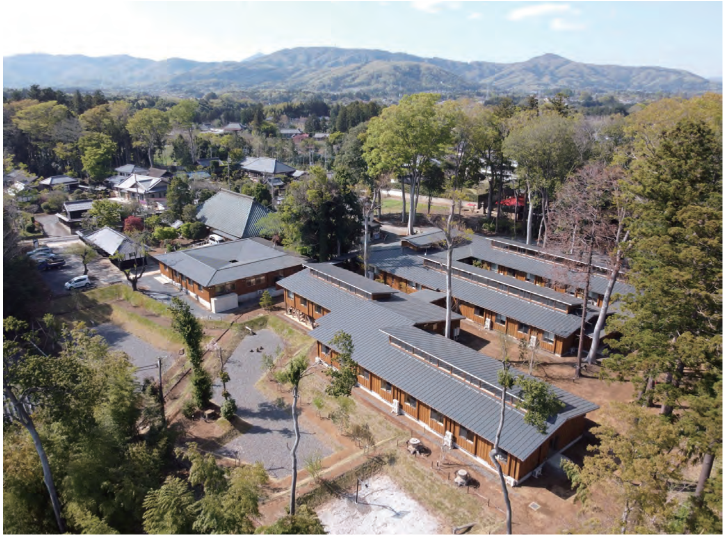
アグリケアガーデンかうすみがうら全景。外来入院棟は正方形の漏斗型の屋根が特徴的。
