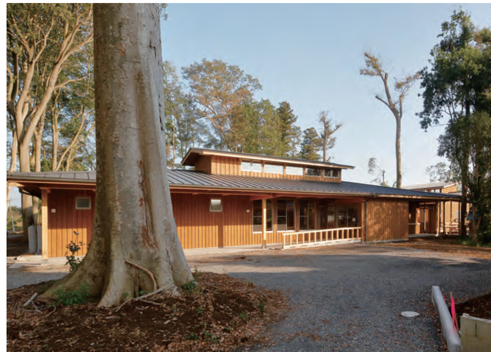
有料老人ホーム棟正面玄関。軒を深く差して来訪者の利便性に配慮した。
