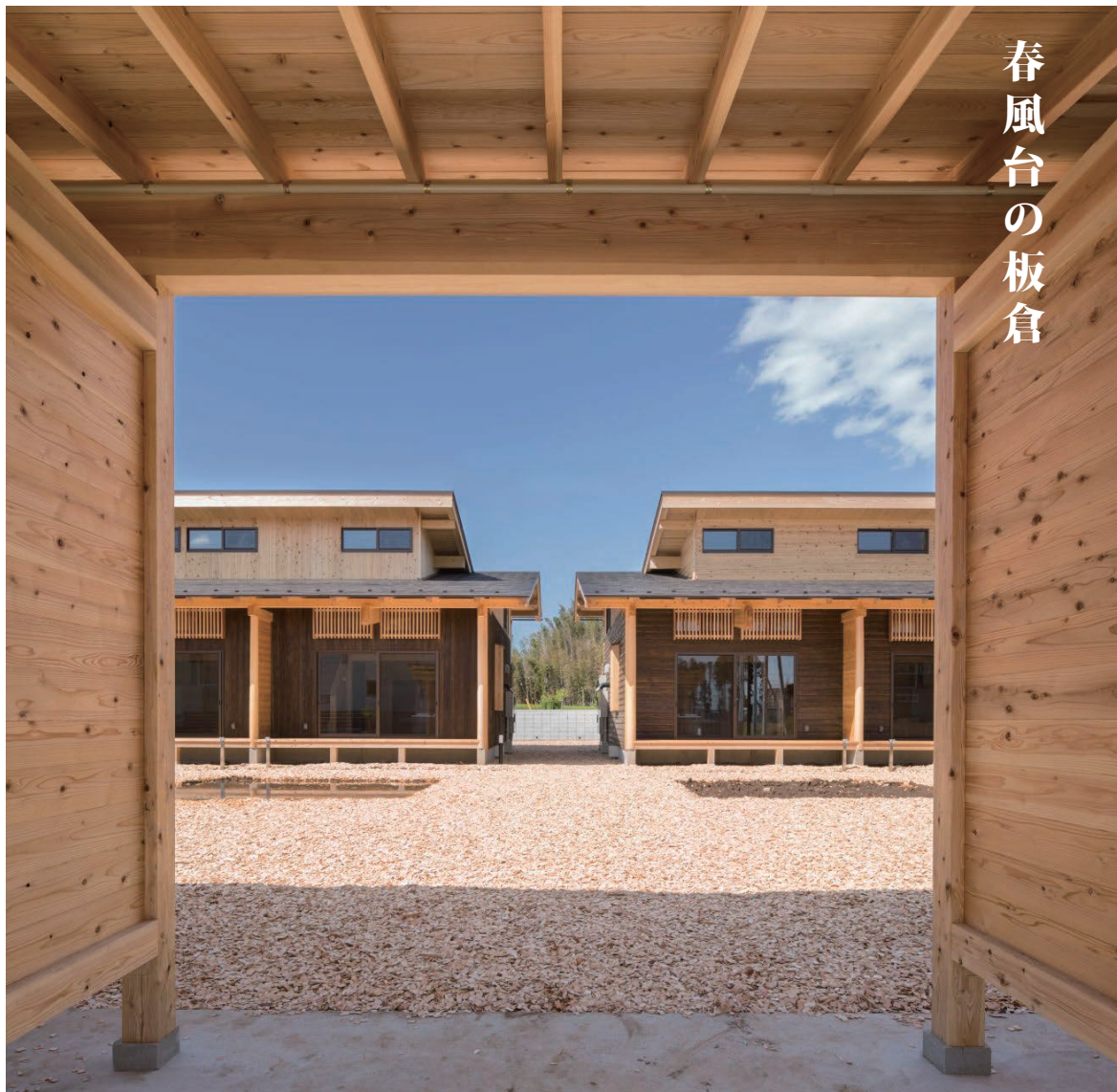
自転車小屋から長屋2棟を望む
