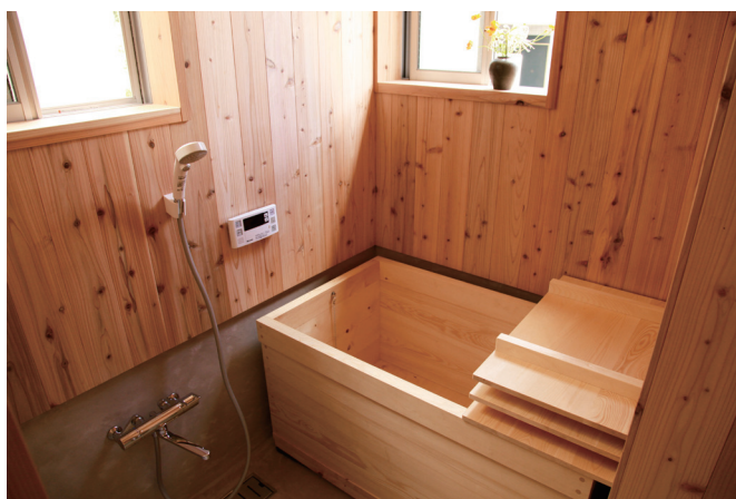
高野横の浴槽が香るスギ板張りの浴室
