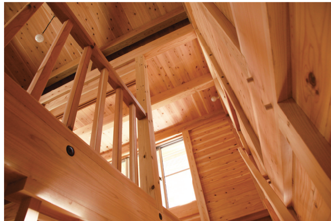
地階から2階まで風の通る階段室
