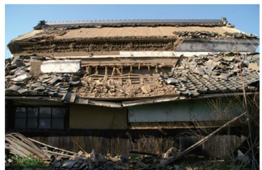
瓦の落下により倒壊した下屋。
