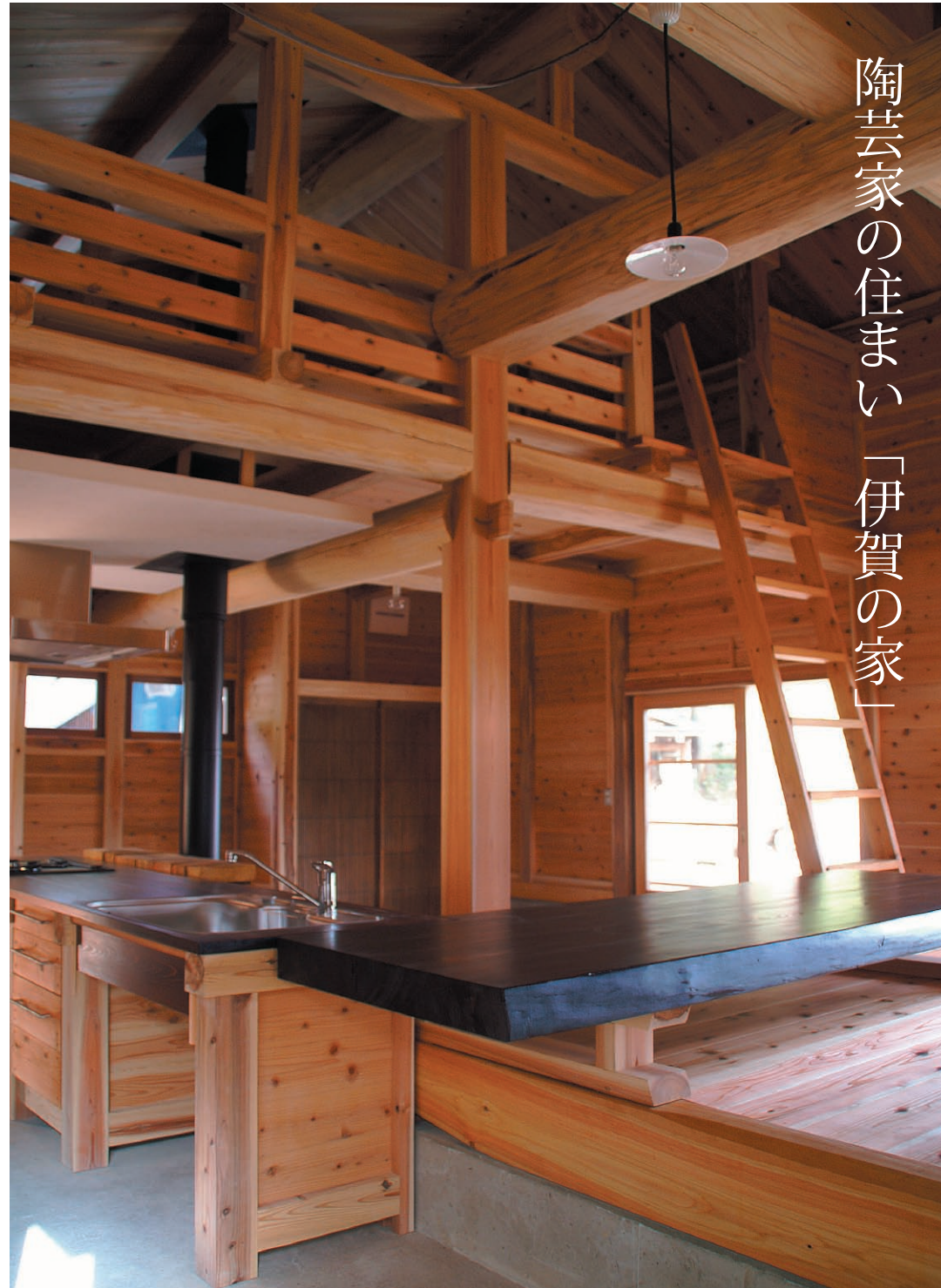
1階の約半分は土間、上にロフトとして寝室を設けている。中央の大黒柱と立派な地棟が家を支える。
