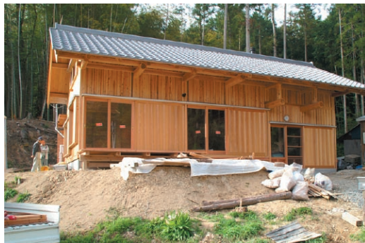
南側には深い軒と広縁を設けた。広縁からの眺めは絶景。
