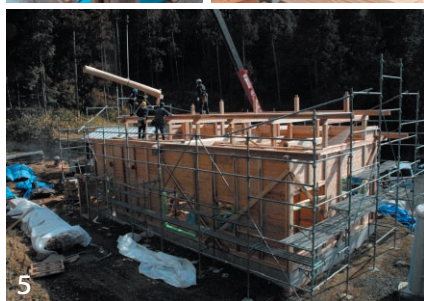
1, 2 冬に伐採後、敷地内で約半年間、葉枯らし乾燥した。 3 伊賀の民家でよく用いられる仕口。ホソを伸ばして鼻栓でとめる。地震などで緩んだ場合でも栓を打ち直すことができる。 4, 5 建て方の様子。
