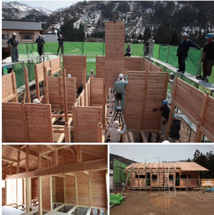
福島県奥会津に試作された仮設住宅。左右対称の長屋、2世帯が入居できるよう設計。
