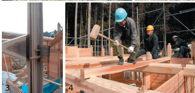
1, 2 冬に伐採後、敷地内で約半年間、葉枯らし乾燥した。 3 伊賀の民家でよく用いられる仕口。ホソを伸ばして鼻栓でとめる。地震などで緩んだ場合でも栓を打ち直すことができる。 4, 5 建て方の様子。
