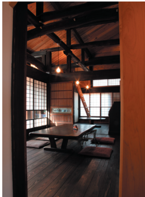
この家の歴史と共に歩んできた古建具が納まる広間。屋根裏の吹き抜けにはマツ丸太の力強い梁組が見える。
