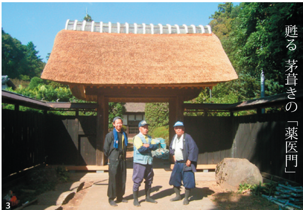
3 葺き替え修理を終えた薬医門
