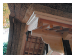
トオシモノとマツの雲型肘木。 茅葺きの一層目は稲ワラ、三層目ま でをトオシモノと呼び、杉皮を挟ん で最外層をミズキリと呼ぶ。
